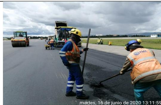
*Extendida, nivelada, control de temperatura y compactada de mezcla P-401 en calle de rodaje Mike entre Echo y Alfa exclusivas. / Aeropuerto Internacional El Dorado (Bogotá)*
