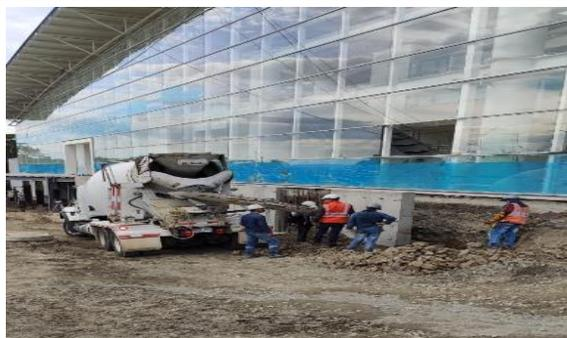
Vaciado de concreto ciclópeo en eje G, Aeropuerto de Armenia
