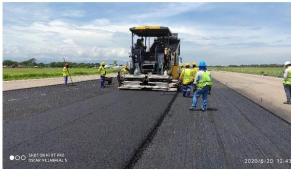
Rehabilitación de la pista extendido de asfalto FAA P 401 Aeropuerto de Valledupar
